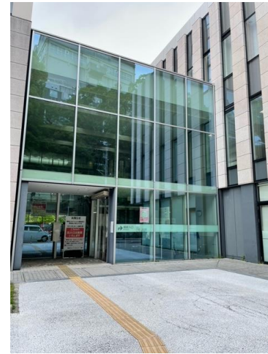
【活水側出入口】
